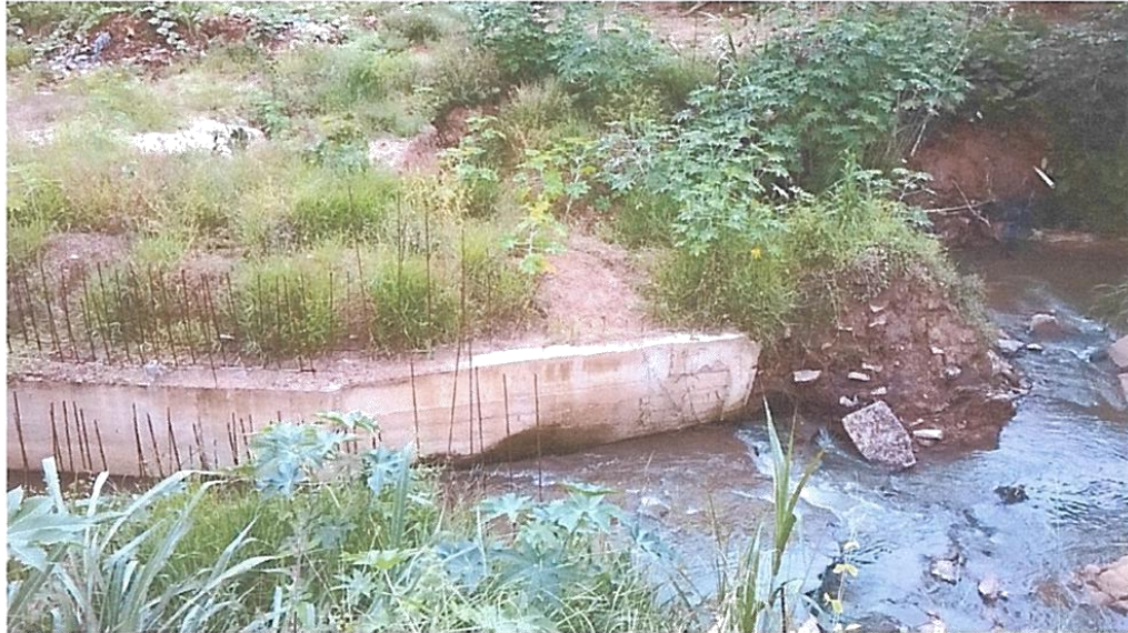
Foto 1 – 1º trecho das paredes da galeria para junção das ruas Padre Vicente Priant e dos Joãos de Barros antes da construção da galeria, abas e arruamento. Foto: Autor, Março de 2015.
